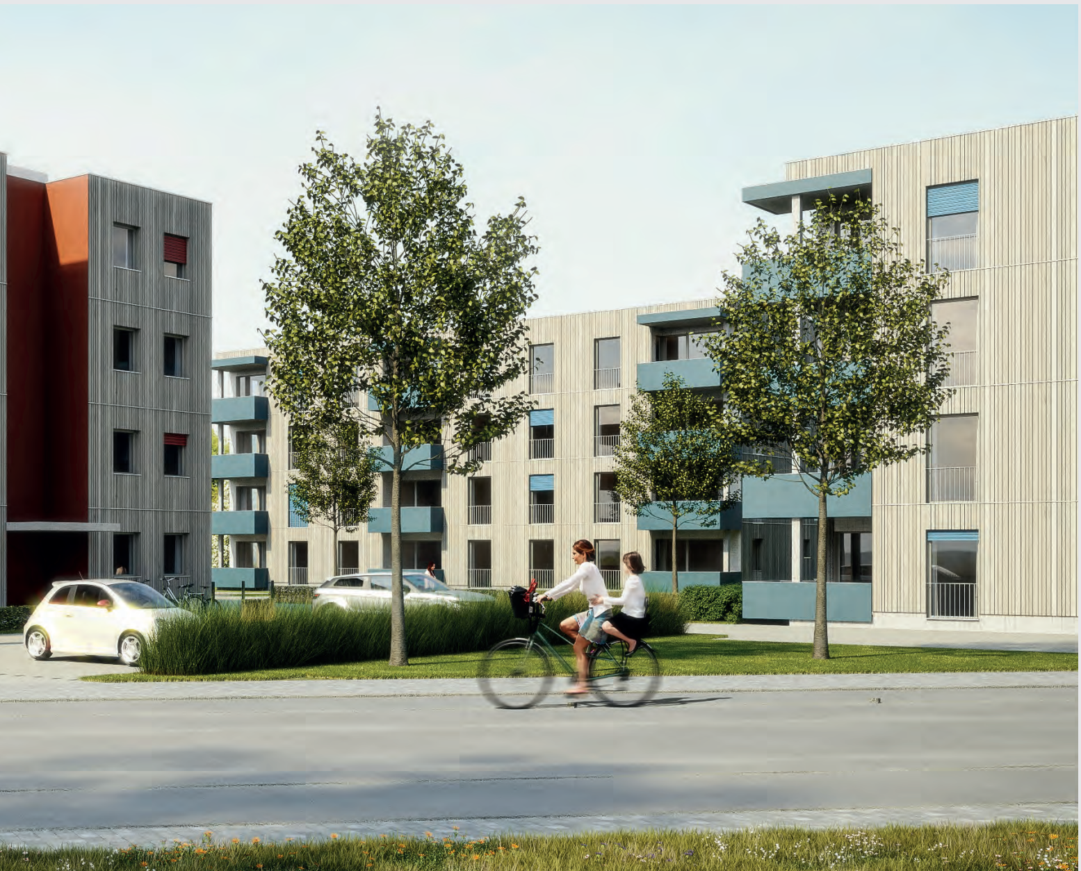
2. Bauabschnitt in Holzbauweise im Quartier Schildacker
