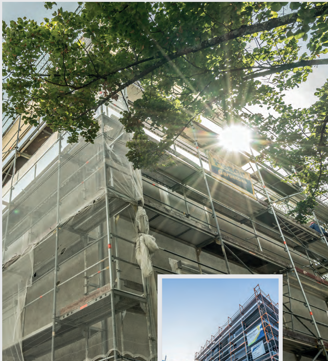
1. Bauabschnitt Neubau Belchenstraße
